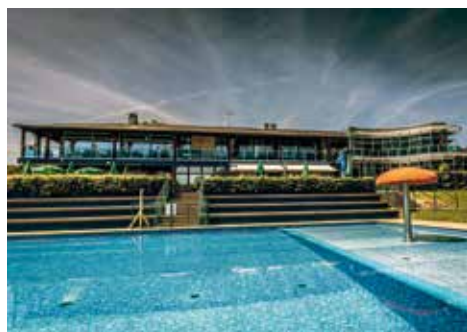
buitenbad met zonne- panelen verwarmd
