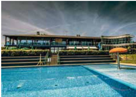
buitenbad met zonne- panelen verwarmd
